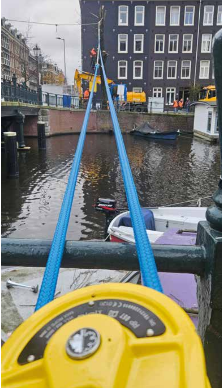
Boom 2 wordt over de gracht heen naar de kademuur toe getrokken.
